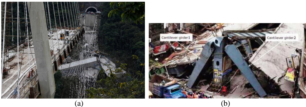
Figura 1. Casos de colapsos de pontes/viadutos durante a execução. (a) Ponte Chijara – Colômbia. (b) Viaduto Kote – Índia.
