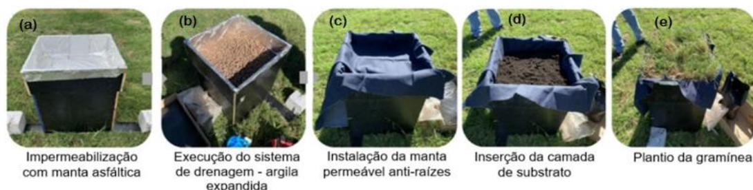
Figura 2 – Procedimento de montagem do telhado verde.
